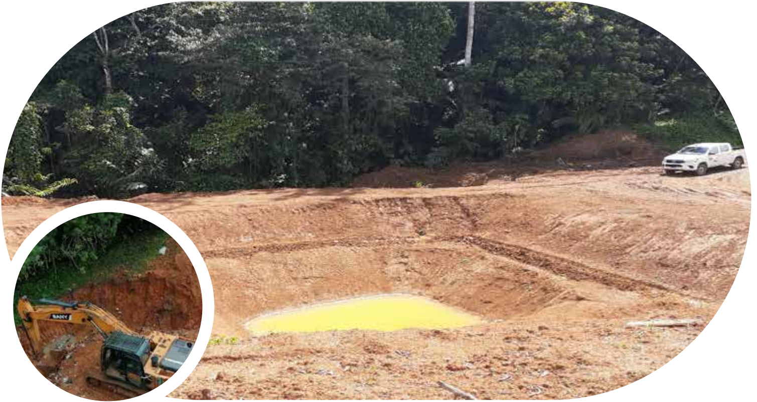
Imágenes de las etapas constructivas (movimiento de tierra) de la Tina de Vertido, en el Relleno de Isla Colón, Bocas del Toro.
