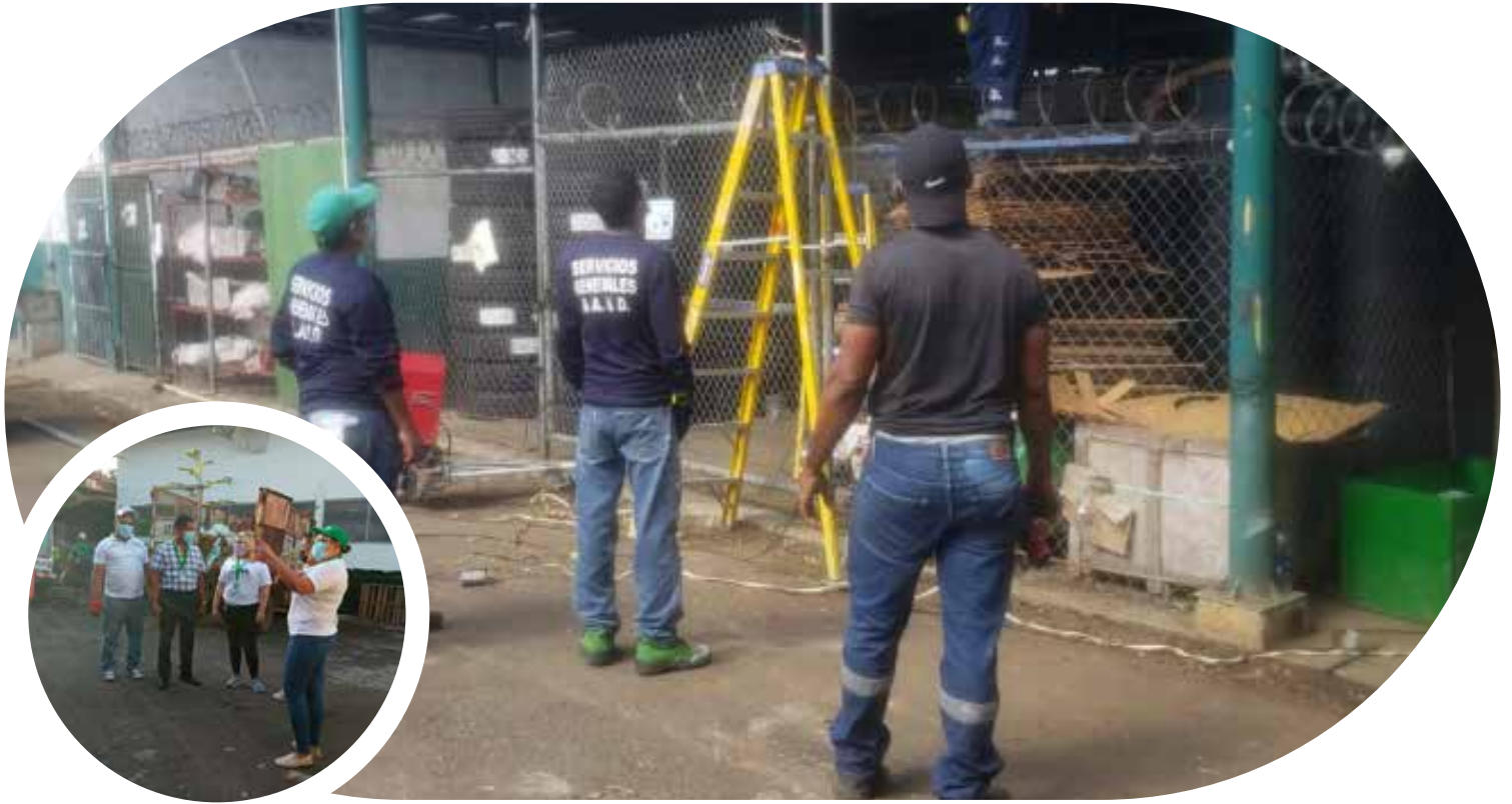
Trabajados realizados por Dirección Administrativa
